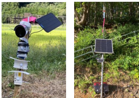
図2 (左) 子機の設置 (右) 中継器の設置
