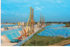
■表紙写真 地下ダム施工写真 (沖縄県国頭郡伊江村)
